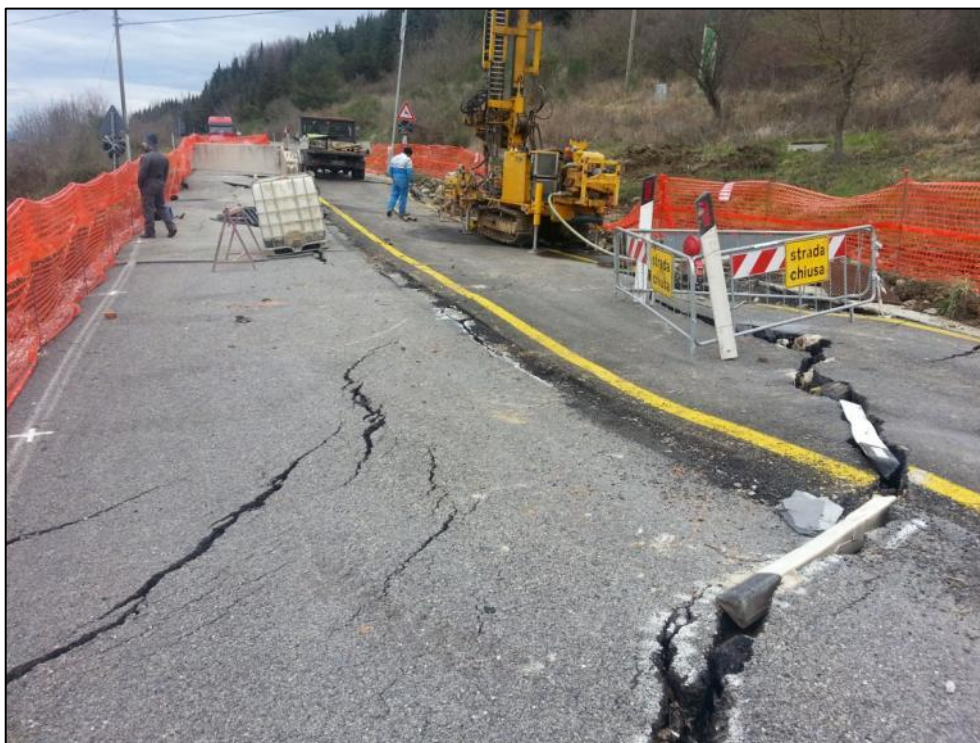
Figura 14: Veduta delle lesioni procedendo in direzione Sesto Fiorentino
